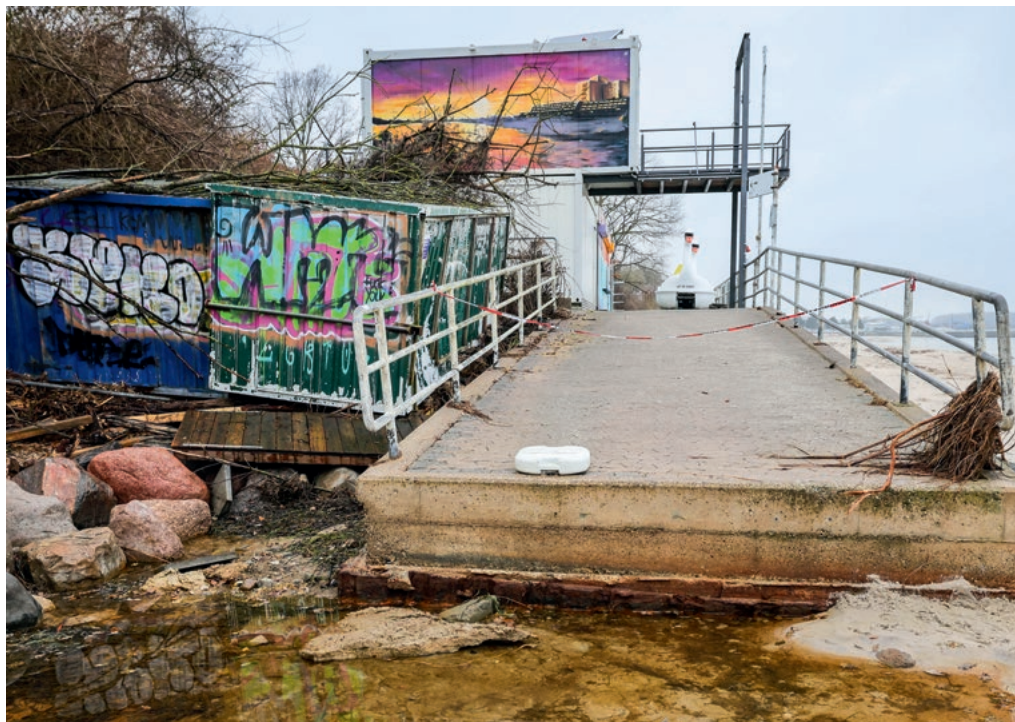
Die Folgen der Sturmflut im Herbst 2023: eine unterspülte Promenade und ein lädiertes Strandkiosk in Kiel-Schilksee
