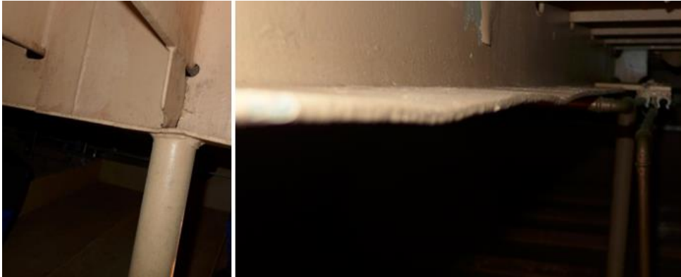
Abbildung 8: Verkrümmung an den Querträger
