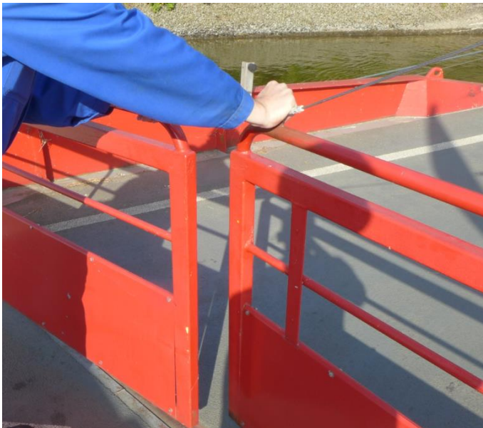
Abbildung 28: Die Pforte in geschlossenen Zustand, Mehr als 50 mm Spiel.
