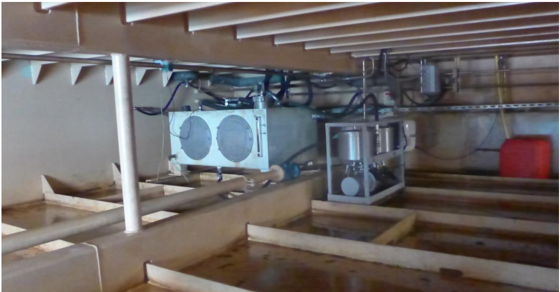
Abbildung 38, Verlauf Brennstoffleitung und Hydraulikaggregat
