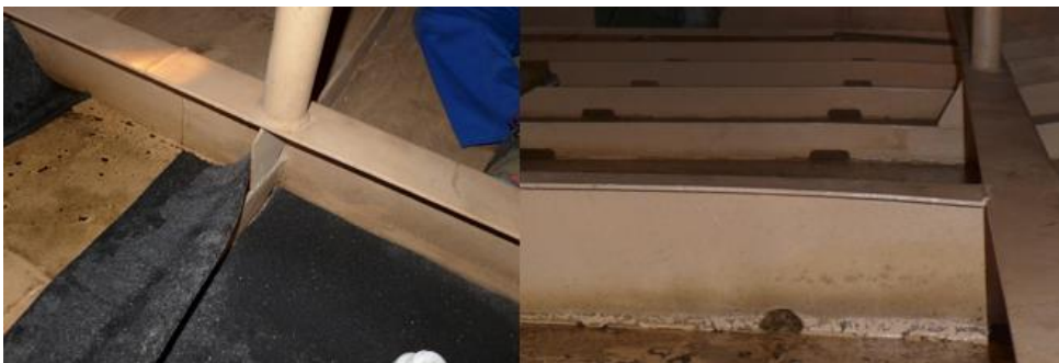
Abbildung 9: Durchbiegung der Balken und Versteifungsprofile
