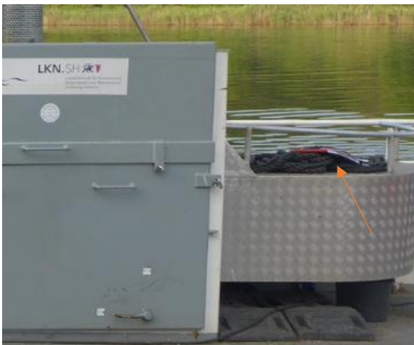
Abbildung 22: Kunststoffseil liegt neben dem Maschinenraum
