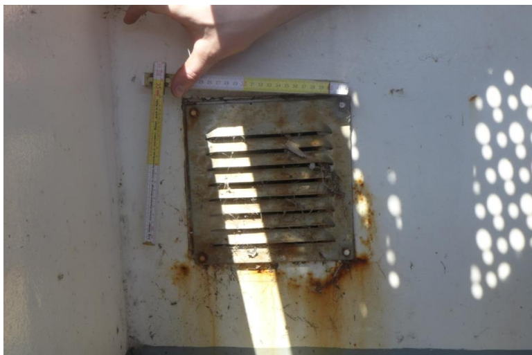
Abbildung 35: Lüftungsgitter Batterieraum
