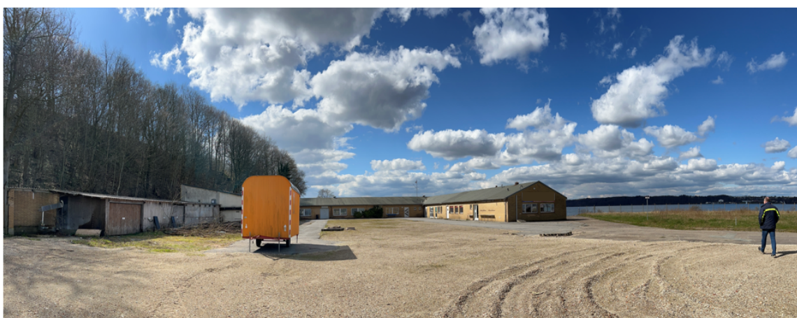
Abbildung 7: Flächenrecyclingvorhaben in Flensburg: Fläche vor Abriss des baufälligen alten Gebäudekomplexes.
