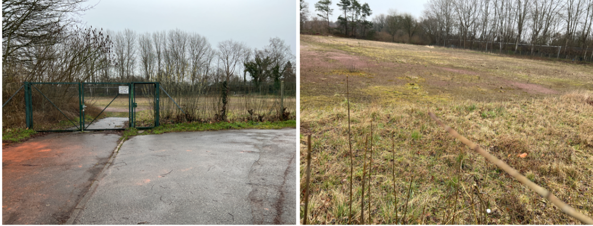
Abbildung 8: Flächenrevitalisierung einer ehemaligen Sportplatzfläche in Kronshagen: Umzäunter und abgesperrter Sportplatz (links) mit einer dichten roten Granulat- und Schlackeschicht, mit teilweise leichtem Bewuchs durch das jahrzehntelange Brachliegen der Fläche (rechts).
